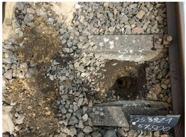
Bild 34: km 57,800, Schurf im Schwellenfach
