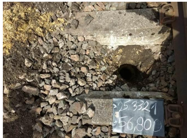
Bild 16: km 56,800, Schurf im Schwellenfach
