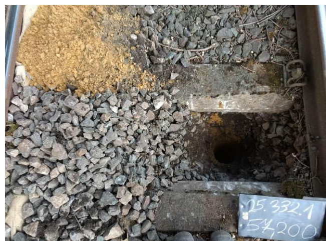
Bild 24: km 57,200, Schurf im Schwellenfach
