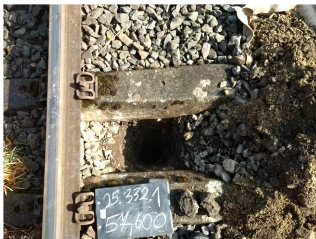
Bild 30: km 57,600, Schurf im Schwellenfach
