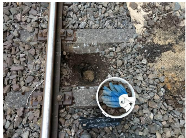
Bild 42: km 58,300, Schurf im Schwellenfach
