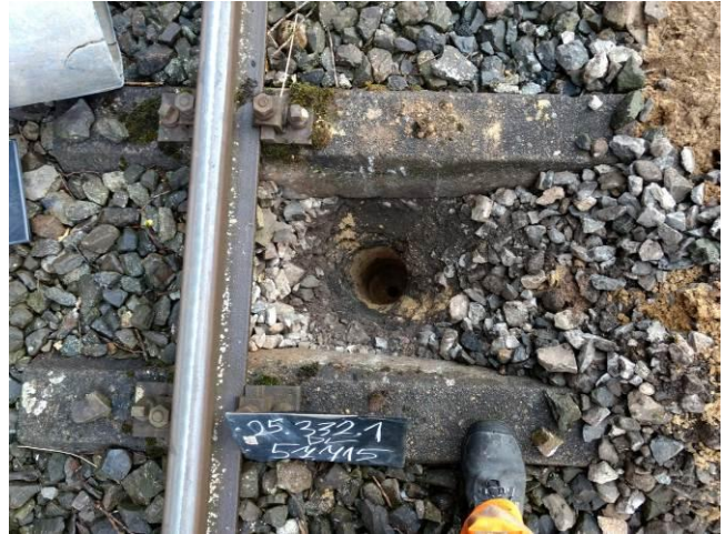
Bild 32: km 57,715, Schurf im Schwellenfach
