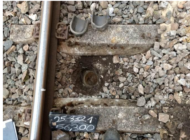
Bild 14: km 56,300, Schurf im Schwellenfach
