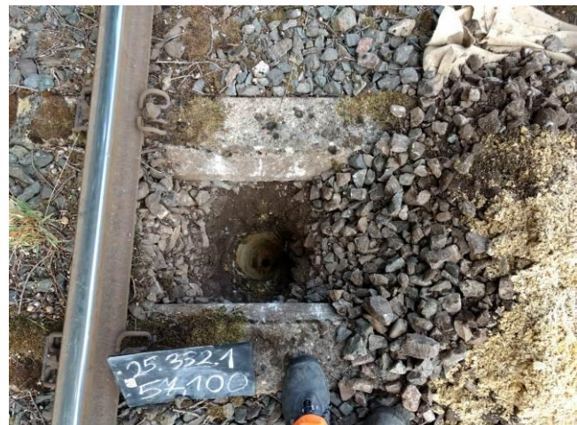
Bild 22: km 57,100, Schurf im Schwellenfach
