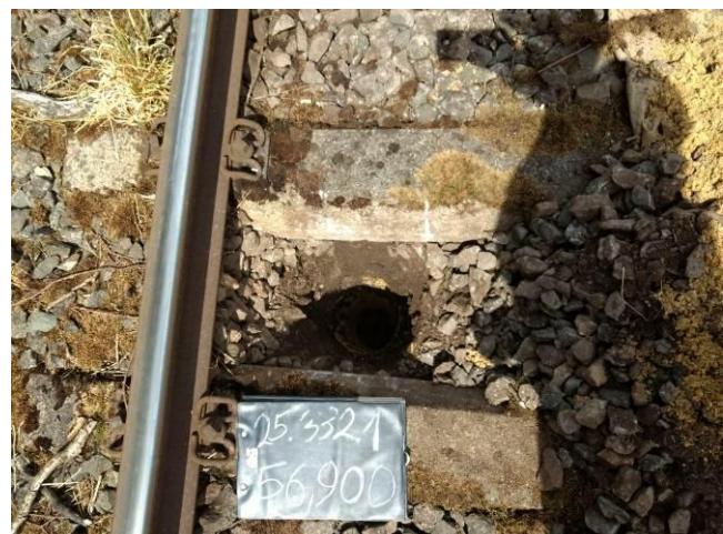
Bild 18: km 56,900, Schurf im Schwellenfach
