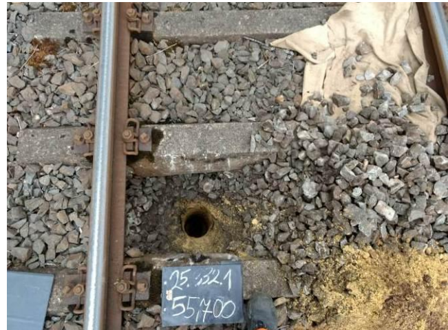
Bild 2: km 55,700, Schurf im Schwellenfach
