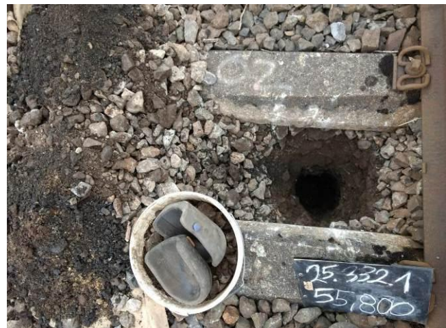
Bild 4: km 55,800, Schurf im Schwellenfach
